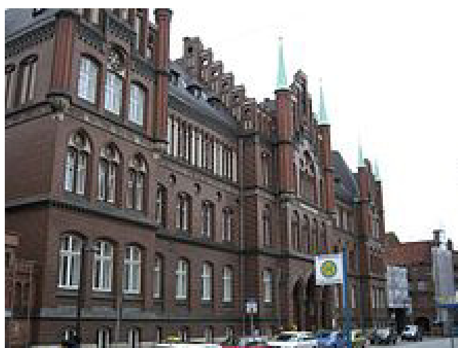
Unter Hoppenstedt erbautes Gerichtsgebäude in Lübeck
